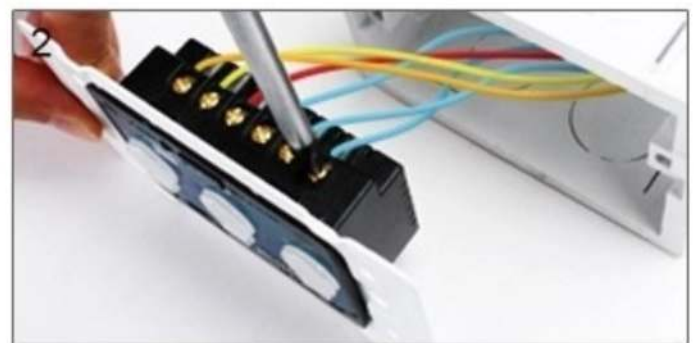
2. Conecteaza firele si strange suruburile.
